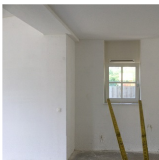
Woonkamer gevel rechts negge raamkozijnstijlen niet recht
