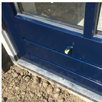
Voorgevel tuindeuren gat in deur naast oog
