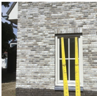
Voor gevel open stootvoegen ontbreken
