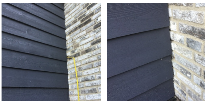
Gevel links aansluiting houten planken met metselwerk voegen ontbreken
