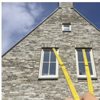
Voor gevel open stootvoegen ontbreken
