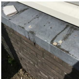
Specie op waterslag voorgevel
